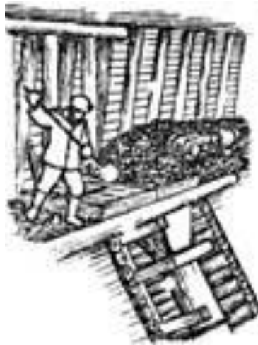
Рисунок 11. Забутовка угля на предохранительной решетке
