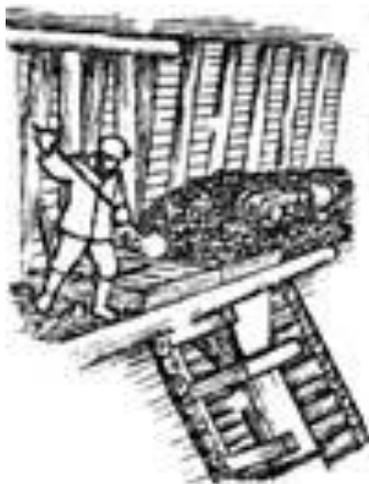
Рисунок 11. Забутовка угля на предохранительной решетке
